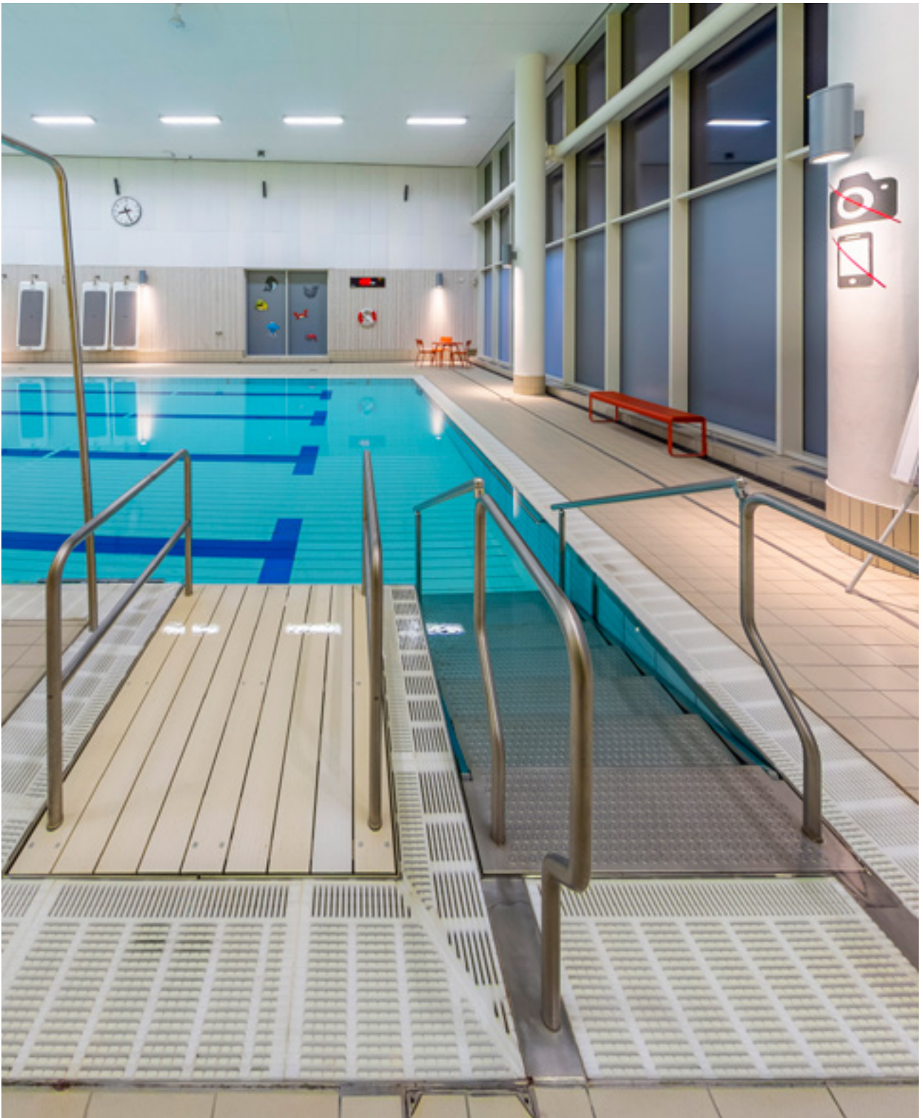
Ramp. Hylliebadet i Malmö har ramper till bassängen med ordentliga ledstänger och tydliga kontrastfärger.
